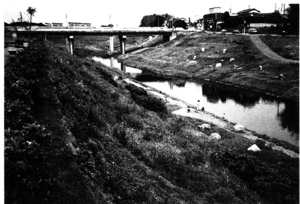
写真 6. 利根運河の現況
